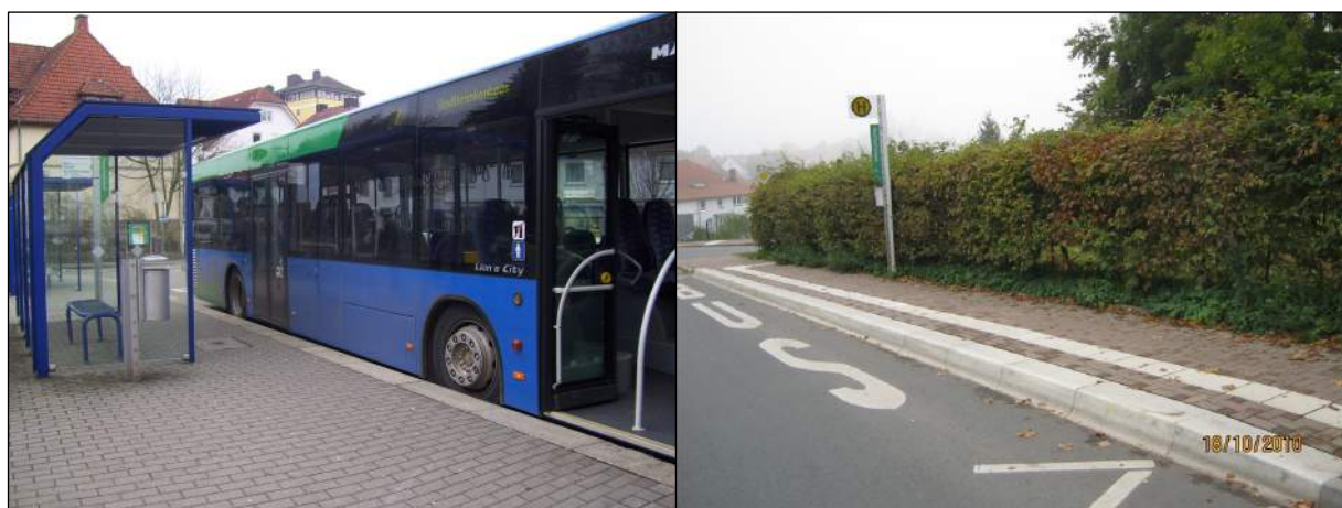
Abb. II-19: Beispiele für Bushaltestellen mit Hochborde: Korbach „Hauptbahnhof“ (links) und Bad Wildungen-Altwildungen „Holzfachschule“ (mit taktilem Leistreifen; rechts)
