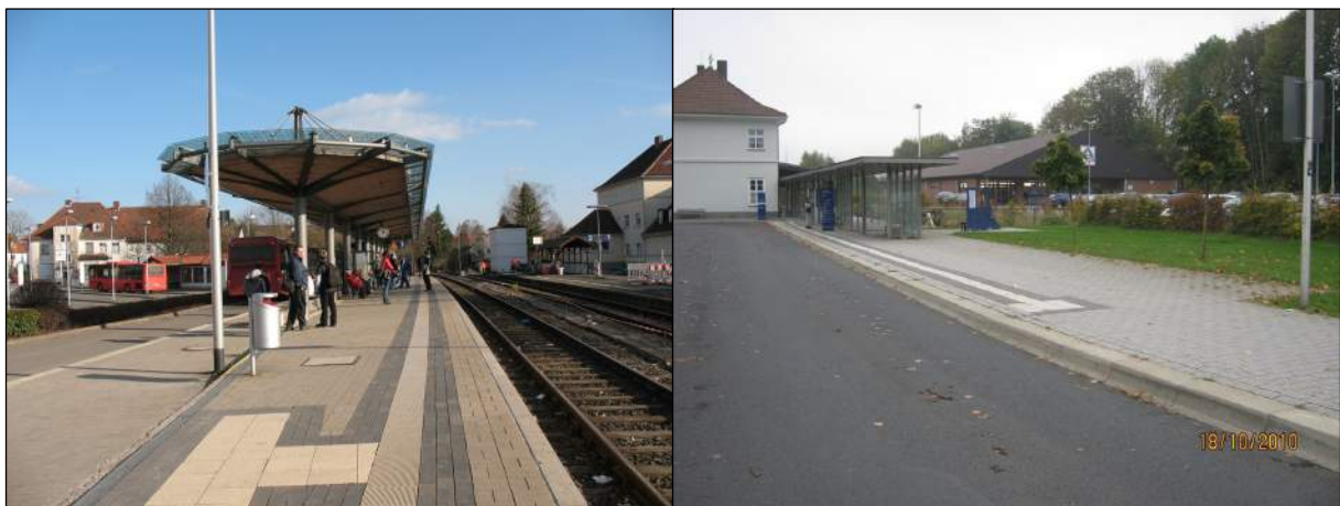
Abb. II-20: Gemeinsame Bus-/Bahnsteige (mit taktilen Leitstreifen): Korbach Hauptbahnhof/ZOB (links) und Bad Wildungen (rechts)
